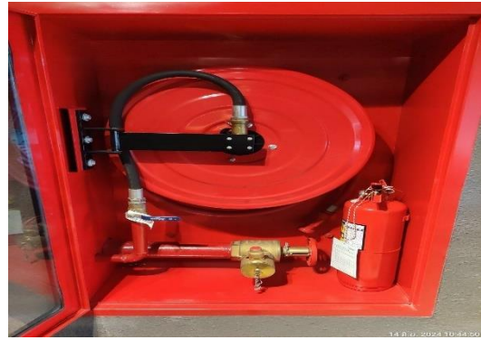
ตู้สายฉีดน้ำดับเพลิงพร้อมอุปกรณ์
