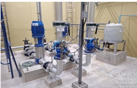
เครื่องสูบน้ำขึ้นใต้ดิน
